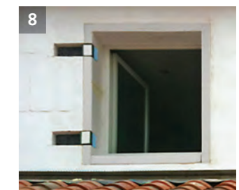
Habitat collectif rénové en enduit mince sur isolant PSE, Courbevoie (Zolpan)
