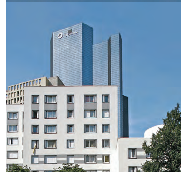
Habitat collectif rénové en enduit mince sur isolant PSE, Courbevoie (Zolpan)
