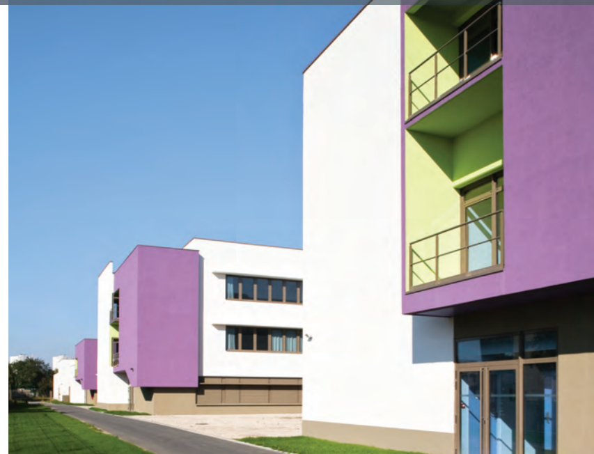
Ci-dessus : Les Lycées Samuel de Champlain, Chennevières s/Marne. Isolation Thermique Extérieure sous enduit épais (Saint-Gobain Weber)
