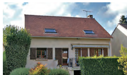
La performance 'maison passive' a été obtenue par mise en place d'un mur manteau sous forme d'une Isolation Thermique Extérieure en PSE graphité d'épaisseur 30 cm, assortie du traitement systématique des points singuliers. De plus, un travail important sur l'étanchéité a permis d'atteindre le niveau requis de 0,6 volume/h sous un écart de pression de 50 Pa (photos : Sto).
