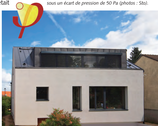
La performance 'maison passive' a été obtenue par mise en place d'un mur manteau sous forme d'une Isolation Thermique Extérieure en PSE graphité d'épaisseur 30 cm, assortie du traitement systématique des points singuliers. De plus, un travail important sur l'étanchéité a permis d'atteindre le niveau requis de 0,6 volume/h sous un écart de pression de 50 Pa (photos : Sto).
